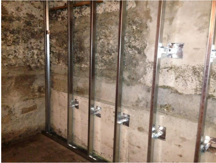
Bild 6 principskiss väggreglar infästning
